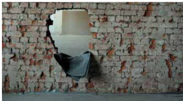
Der Durchbruch – aus drei kleinen wurden zwei große Unterrichtsräume gemacht.
